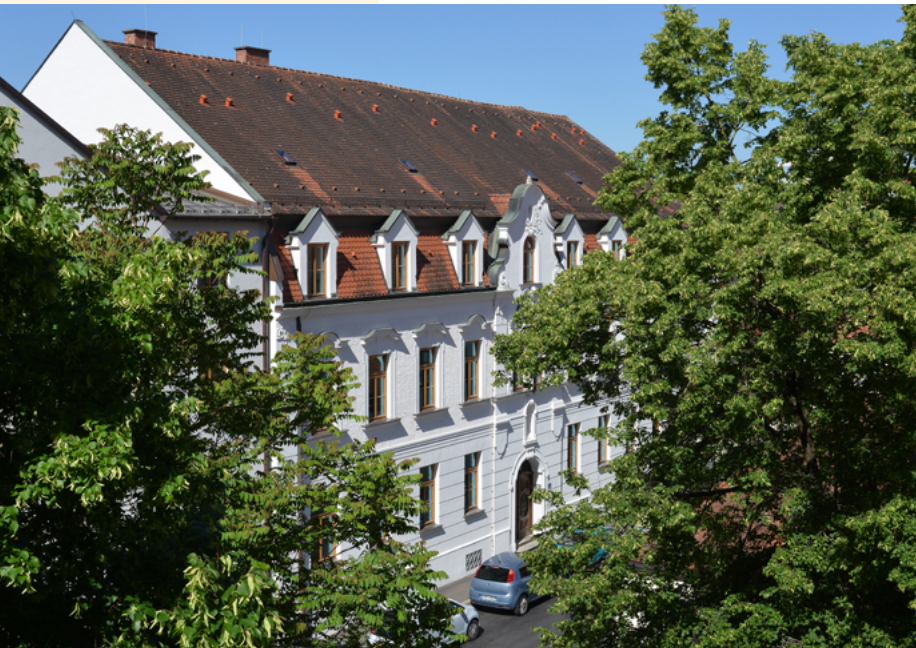
Nardini-Haus, Ingolstadt, Griesbadgasse 14 und 18 (© Fotos: Werner Prokschi, Eichstätt)
