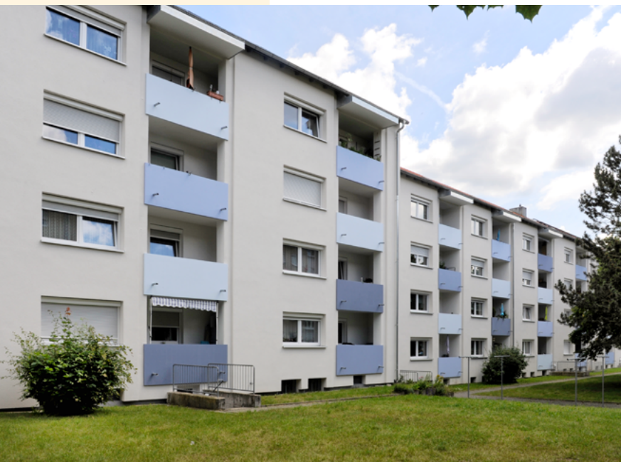
Modernisierung von insgesamt 96 Mietwohnungen: Schwabach, Wilhelm-Albrecht- Straße 8-30
